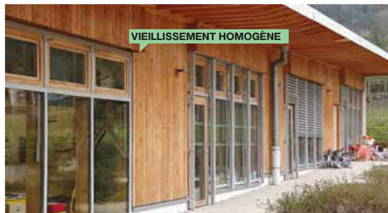
**Figure 3 :** Débord de toiture suffisant à l'école élémentaire de La Rivière (38) par RIGASSI et Associés Architectes. (© Fibois 38, Fibois 07/26, Fibois AURA et CAUE 38)
