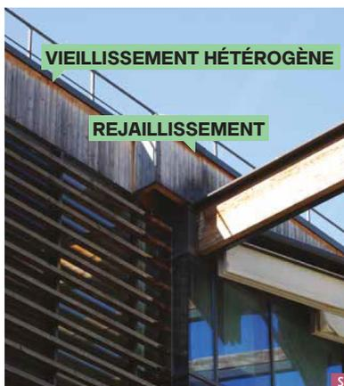
**Figure 2 :** Vieillissement influencé par la couvertine et la poutre au Centre commercial de Bonne (38) par Groupe 6. (© Fibois 38, Fibois 07/26, Fibois AURA et CAUE 38)
