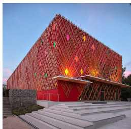
© Marie Caroline Lucat / architecte : A + Architecture
